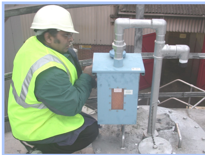
Respirateur 615 monté avec soupape de surpression.
