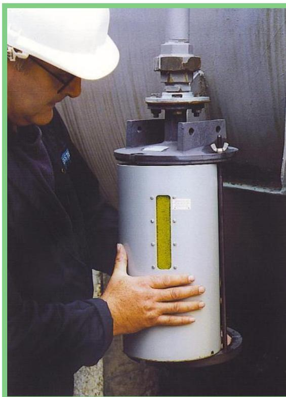
Les respirateurs pour transformateurs se remplacent en quelques minutes. (Illustration : taille W)
